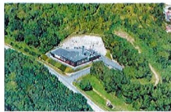
Illustration: Chaufferie biomasse de Maromme (2+7 MW bois)
