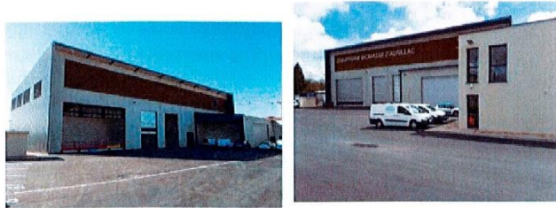
Illustration: Chaufferie biomasse d'Aurillac (3,5 + 6,5 MW bois)
